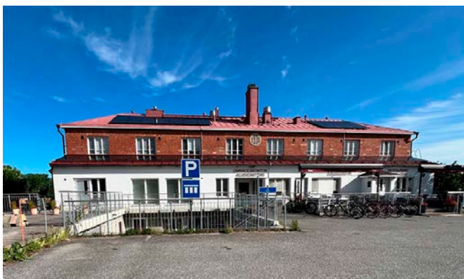
Stabshusets södra fasad Stabshusetin eteläjulkisivu
