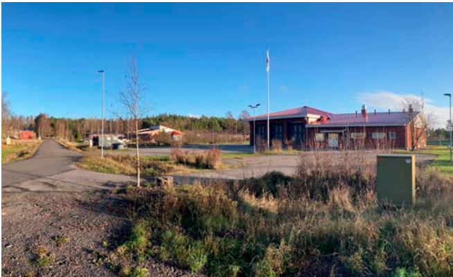
Brandstationen på Tallbackavägen Paloasema Mäntymäentiellä
