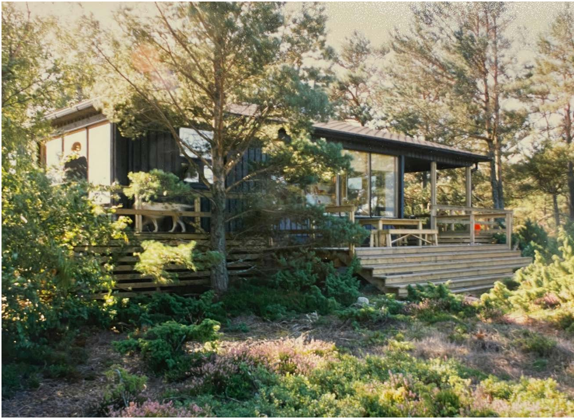
Det befintliga fritidshuset på Östernorrholm, bilden tagen från norr.
