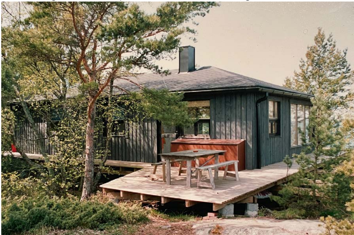
Det befintliga fritidshuset på Östernorrholm, bilden tagen från sydost.
