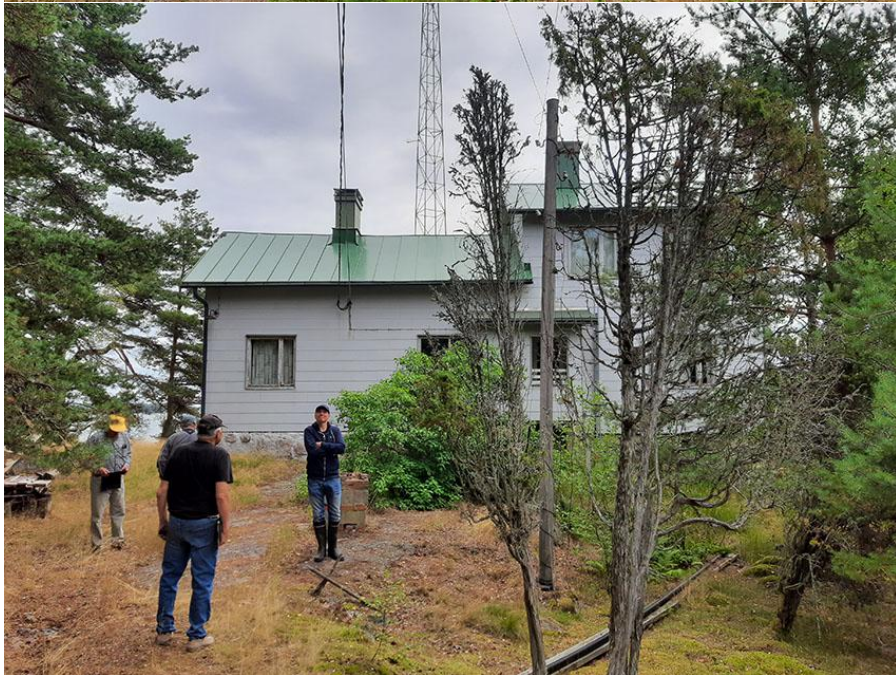
Bilder 2-3. Lotsstationens stationsbyggnad avbildad från öster (ovan) och väster. Byggnaden är sedan förstoringsrenoveringen i ursprungligt skick inklusive inredningen. Den lägre delen är från 1898 och förstoringen i två våningar från 1950-talet. På den östra sidan finns en ur bruk tagen telekommunikationsmast, som i något skede torde tas ned av säkerhetsskäl. Den gamla telefon- eller elektricitetsstolpen minner om gångna tiders tekniska framgångshistorier. Enligt en utredning som Museiverket låtit göra är Timmerholmens byggnadskulturhistoriska betydelse ringa. Byggnadens storlek är 120 m 2 .
