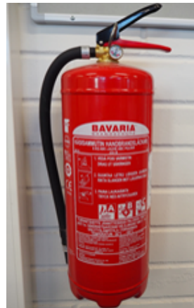
Handbrandsläckare (pulver)
