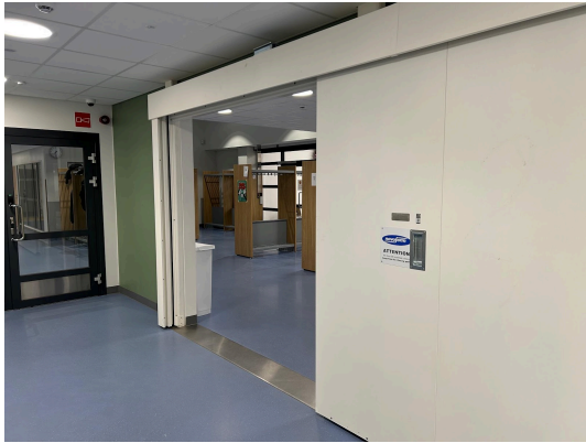
Skjutbranddörr med automatisk stängning i B-trapphuset
