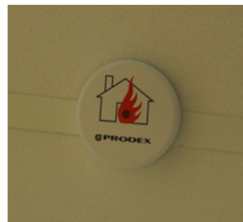
Branddetektor i mellantaket
