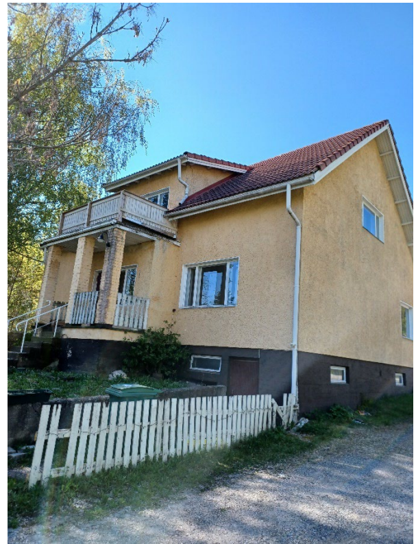
Huvudbyggnaden på fastigheten Gläntan 3:41. Kiinteistöllä Gläntan 3:41 oleva päärakennus.
