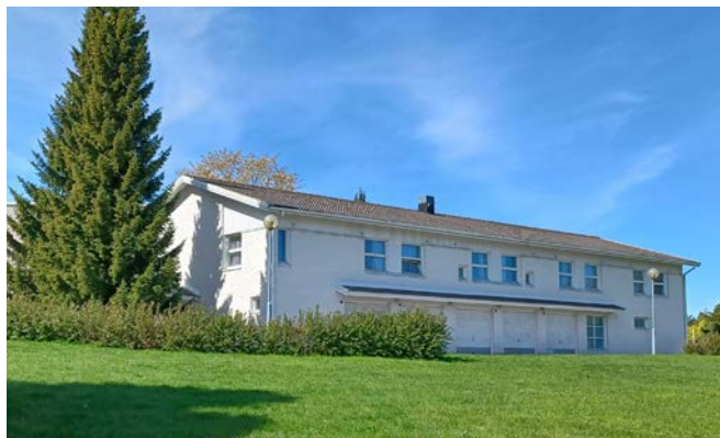
Internatbyggnad från 1990-talet Asuntolarakennus 1990-luvulta
