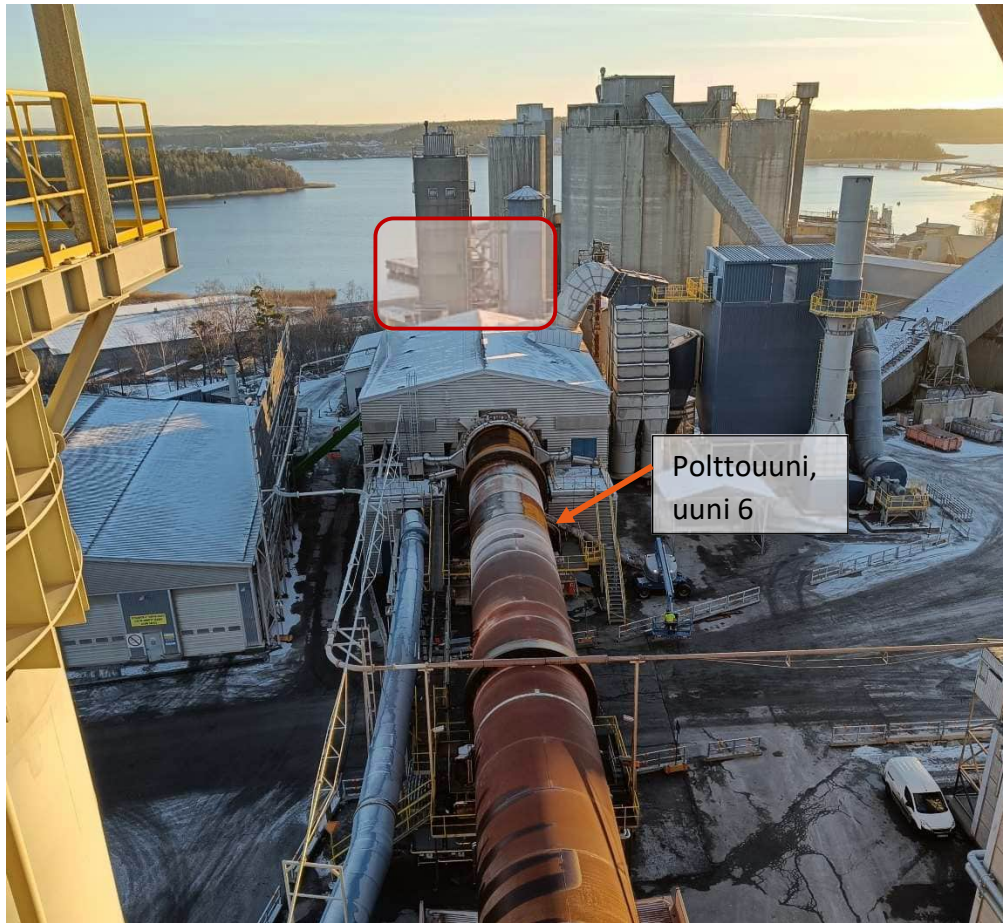
Kuva 3. Kuivaimen sijainti havainnollistettu kuvaan punareunaisella kuviolla. Kuivaimen kokonaiskorkeus jää oikealla puolella näkyvän piipun kokonaiskorkeudelle.
