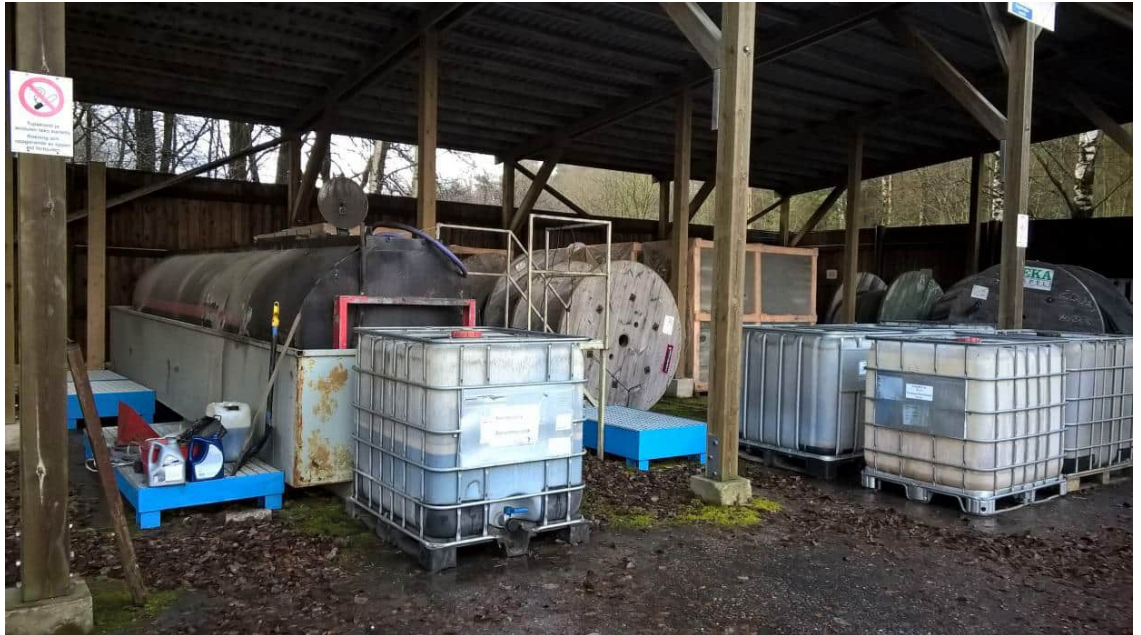
Kuva 7. Vanha kierrätyspolttoöljysäiliö, jota ollaan poistamassa käytöstä, sekä pienempiä kierrätyspolttoöljykuutioita, joiden käyttöön ollaan siirtymässä.
