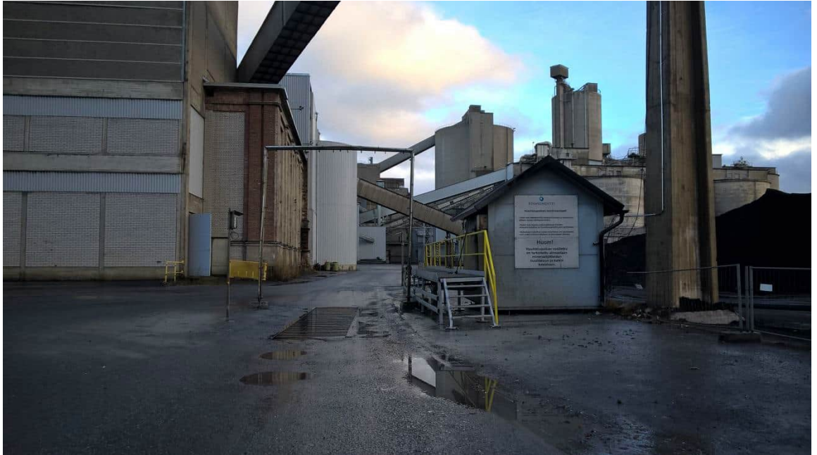
Kuva 16. Autonpesupaikka ja öljynerotuskaivon kannet.
