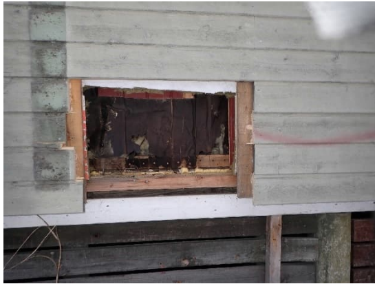
Kuvat 29 ja 30. Avauksessa R4 havaittiin kosteusjälkiä ja mustumista runkokuuissa. Avauskohdan yläpuolella on ikkunan reuna.
