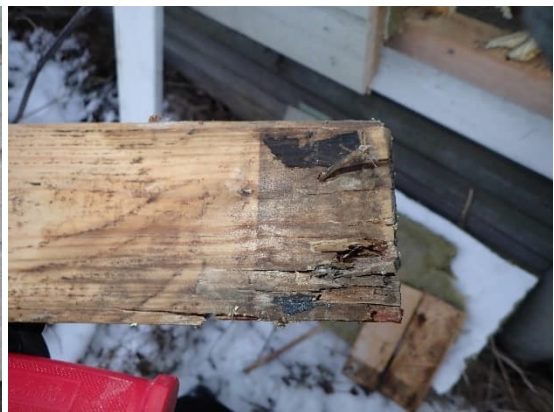
Kuvat 33 ja 34. Avauksen R6 kohdalla vanhan verhouksen alareuna oli lahonnut.
