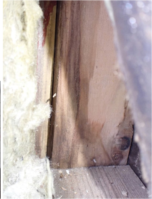
Kuvat 29 ja 30. Avauksessa R4 havaittiin kosteusjälkiä ja mustumista runkokuuissa. Avauskohdan yläpuolella on ikkunan reuna.
