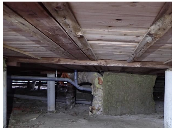
Kuvat 6 ja 7. Ryömintätilassa on hiekkamaata ja paikoin orgaanista rakennusjätettä. Alapohjan on eristetty osin alapuolelta ilman tuulensuojakerrosta. Viemäreistä osa on eristämättä.
