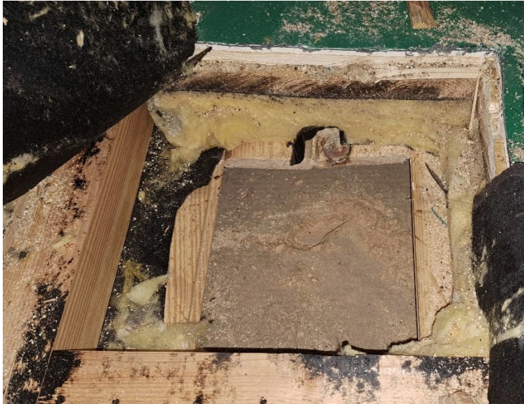
Kuva 5. Alapohjan rakenteet liikuntasalin kohdalla huokoiseen puukuitulevyyn asti.
