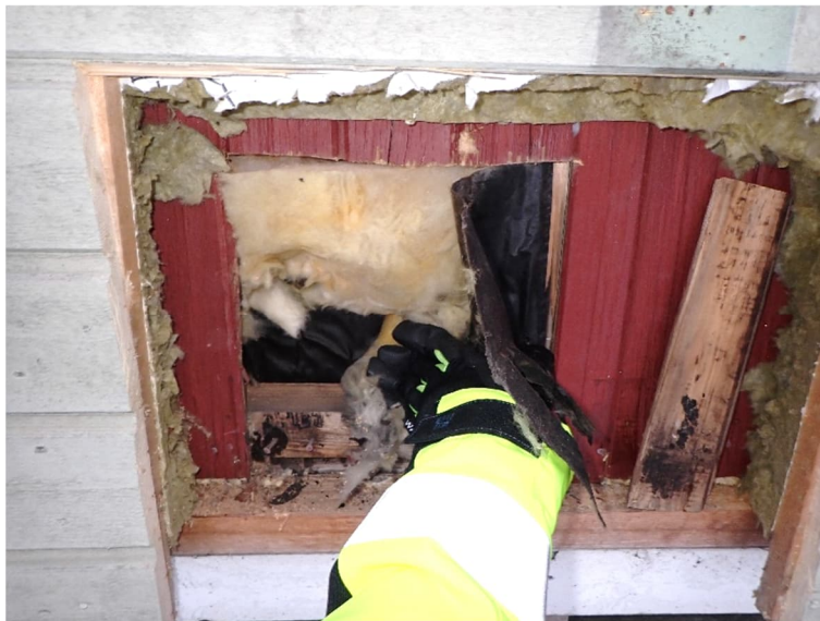
Kuva 20. Ulkoseinä on lisäeristetty ulkopuolelta ja rakenteen sisällä on vanha punainen ulkoverhous,
