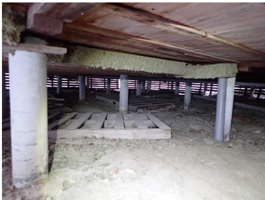
Kuvat 6 ja 7. Ryömintätilassa on hiekkamaata ja paikoin orgaanista rakennusjätettä. Alapohjan on eristetty osin alapuolelta ilman tuulensuojakerrosta. Viemäreistä osa on eristämättä.
