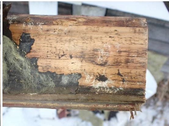
Kuvat 31 ja 32. Avauksen R5 kohdalla havaittiin näkyvää mikrobikasvustoa (ympyrä) runkokuuissa ja valkoista rihmastoa vanhan ulkoverhouksen taustapinnalla.
