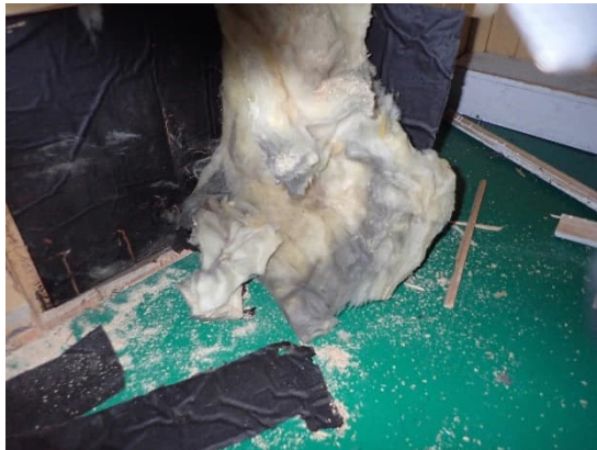
Kuvat 25 ja 26. Vasemmanpuoleisessa kuvassa avauksen R1 lämmöneristeissä on runsaasti ilmavirtauksen aiheuttamaa mustumista. Oikeanpuoleisessa kuvassa avaus R2.
