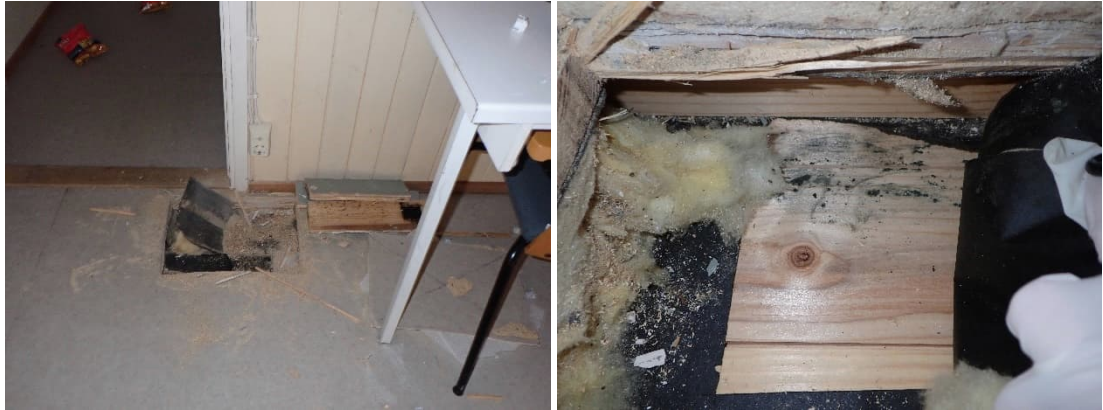
Kuvat 18 ja 19. Avauksen R17 kohdalla alemman tervapaperin alla olevassa laudassa havaittiin näkyvää mikrobikasvua.
