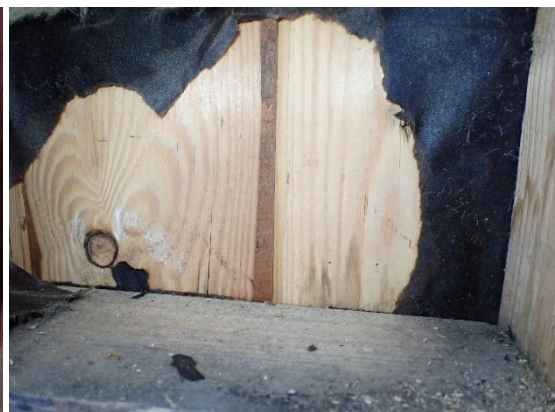
Kuvat 27 ja 28. Avauksessa R3 todettiin kosteusjälkiä runkopuussa ja sisäverhouslaudassa taustapinnassa. Avauskohdan yläpuolella on ikkuna.
