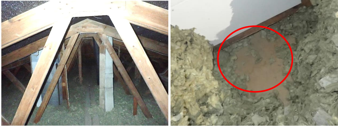
Kuvat 39 ja 40. Yleiskuvaa yläpohjatilasta ja kosteusjälki puhallusvillan alla.
