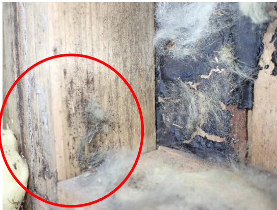
Kuvat 31 ja 32. Avauksen R5 kohdalla havaittiin näkyvää mikrobikasvustoa (ympyrä) runkokuuissa ja valkoista rihmastoa vanhan ulkoverhouksen taustapinnalla.
