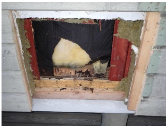
Kuvat 33 ja 34. Avauksen R6 kohdalla vanhan verhouksen alareuna oli lahonnut.
