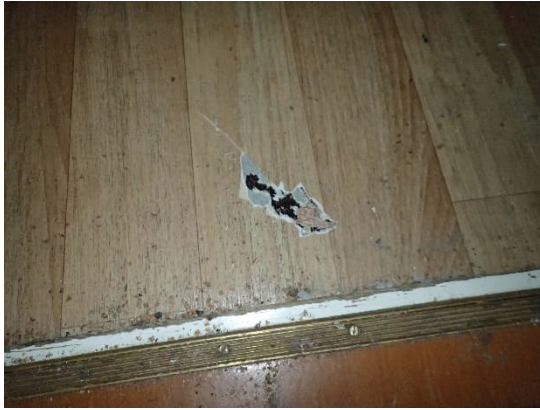
Kuva 5. Näyte AH5 Eteisen wc:n lattian puukuvioitu muovimatto ei sisällä asbestia.
