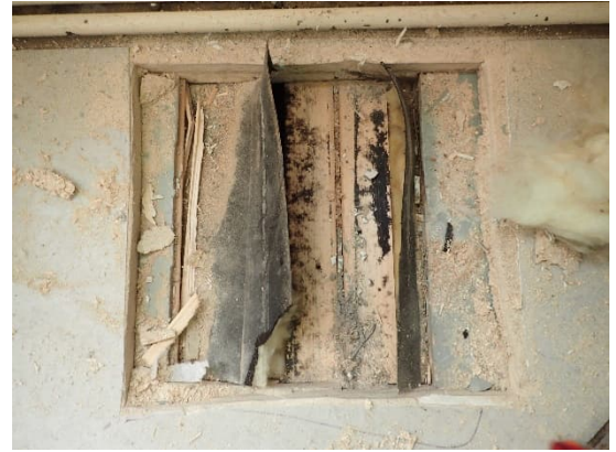
Kuva 10. Näyte AH11. Rakennuksen puuelementtien saumoissa oleva elementtien saumakitti ei sisällä asbestia.
