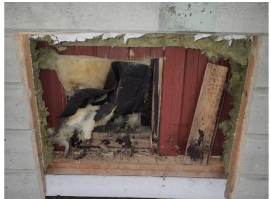
Kuva 8. Näyte AH9. Rakennuksen ulkoseinien tuulensuojana oleva tervapaperi ei sisällä asbestia eikä sen PAH(16)-yhdisteiden kokonaispitoisuus ylitä vaarallisen jätteen raja-arvoa.
