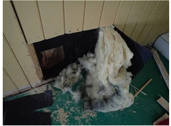
Kuva 6. Näyte AH7. Rakennuksen ulkoseinien ilmansulkuna käytetty tervapaperi ei sisällä asbestia eikä sen PAH(16)-yhdisteiden kokonaispitoisuus ylitä vaarallisen jätteen raja-arvoja.
