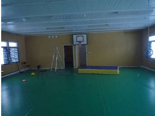
Kuva 1. Näyte AH1. iikuntasalin ja välinevaraston lattiassa käytetty muovimatto ei sisällä asbestia.
