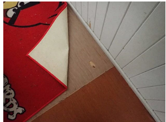
Kuva 4. Näyte AH4. Eteisen ja wc:n lattian rusehtava muovimatto ei sisällä asbestia.
