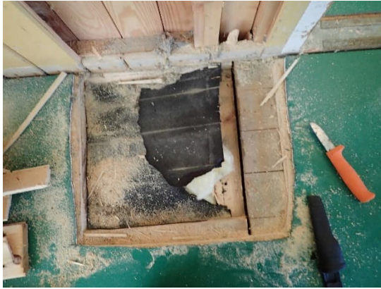
Kuva 9. Näyte AH10. Rakennuksen alapohjan tervapahvii ei sisällä asbestia eikä sen PAH(16)-yhdisteiden kokonaispitoisuus ylitä vaarallisen jätteen raja-arvoja.
