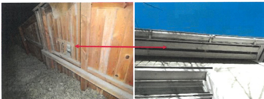
Kuvat 15 ja 16. Yläpohjatilan tuuletus on aistinvaraisesti arvioituna riittävä.
