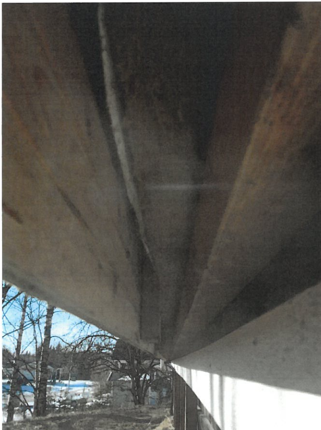
Kuva 10. Ulkoseinät on lisälämmöneristetty ja ulkovuoraus on uusittu.
