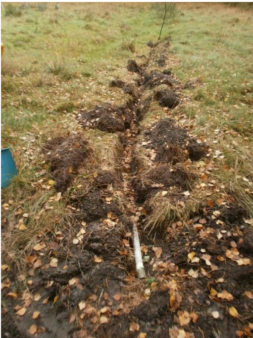
Bild 2a-b. Igenpluggat dräneringsrör i dike nr 3 Kuva 2a-b. Tulpattu salaojaputki ojassa nro 3
