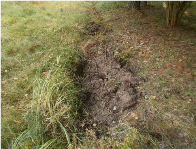
Bild 4. Nedre ändan på dräneringsrören eftersöktes med spade
