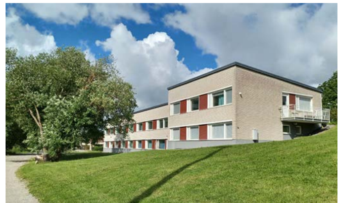
Internatbyggnad från 1960-talet Asuntolarakennus 1960-luvulta
