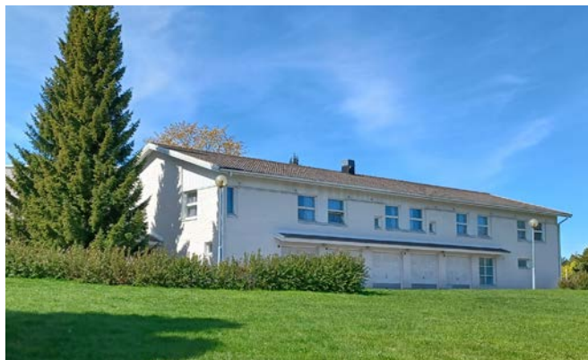
Internatbyggnad från 1990-talet Asuntolarakennus 1990-luvulta
