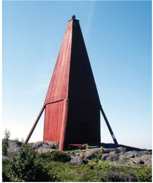
Härkmeren tunnusmajakka, rungon ulkopuolella erottuvat vinotuet estävät merimerkin kaatumisen kovalla tuulella.
