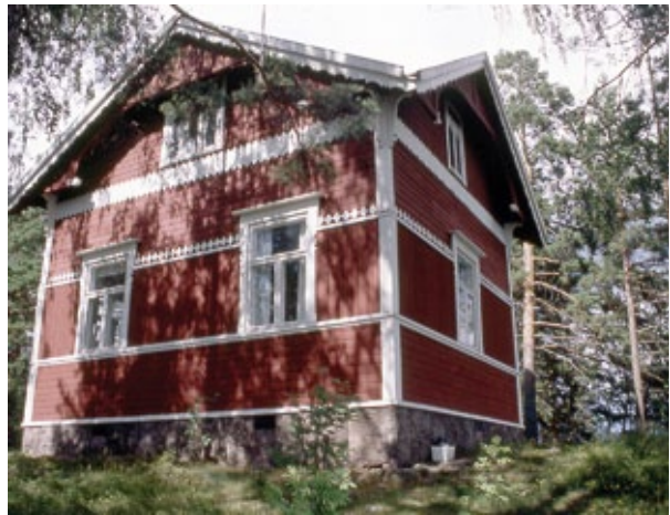
Björkholmin luotsivartiotupa muuttui sittemmin Merenkululaitoksen henkilökunnan varausmökiksi.
