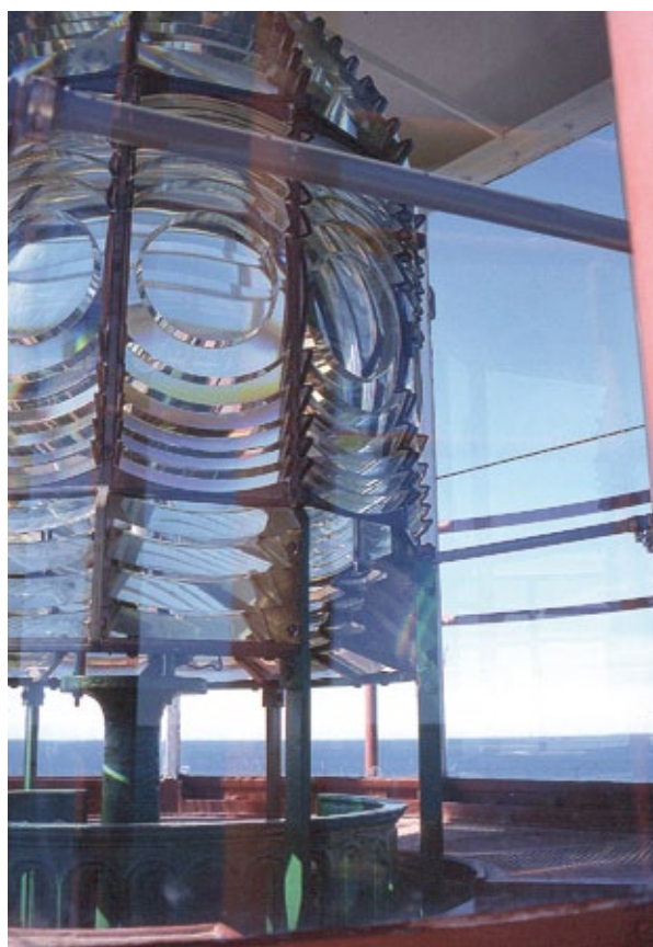
Kaskisten Sälgrundin majakan linssistö. Merkittävä tekniikanhistoriallinen detalji ja majakanvartijoiden tärkein huolenpidon kohde.
