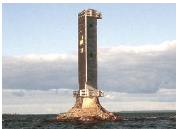
Massiivinen betoniloisto, Santosenkari ylempi.
