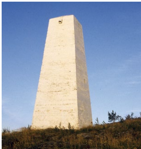
Kejsarkubbanin betonikummeli opastaa Pietarsaaren.
