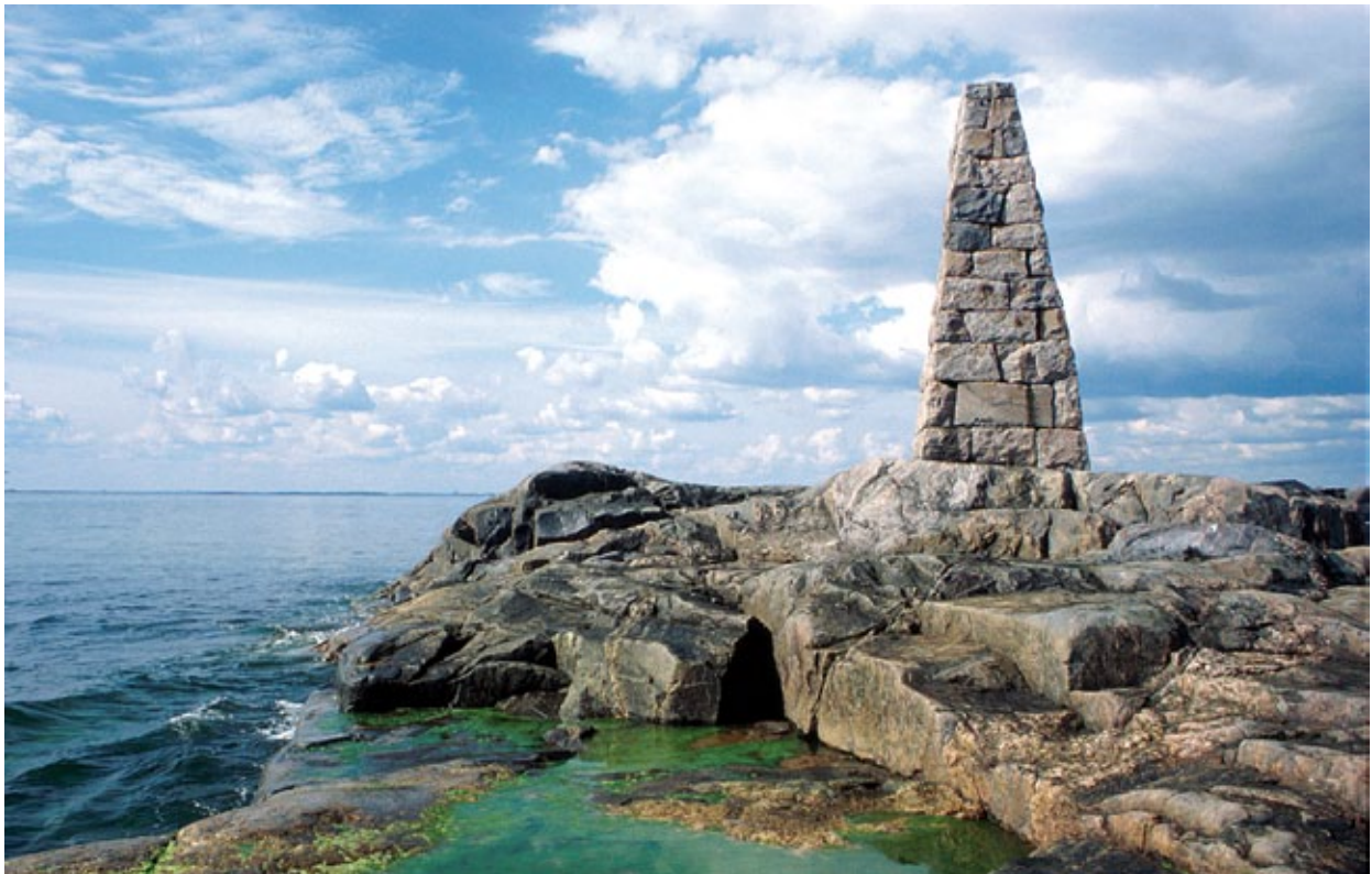
Svartbådanin jyhkeä tornikummeli Helsingin ulkosaaristossa on Harmajan majakan pari. Väylä kaupunkiin kulkee merkkien välistä.
