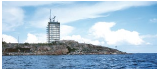
Hangon Tulliniemen satama on Suomen merkittävimpiä tuonti- ja vientisatamia. Sen vuonna 1952 valmistunut luotsiasema oli inventointia tehtäessä rakennustelineiden ympäröimä.
