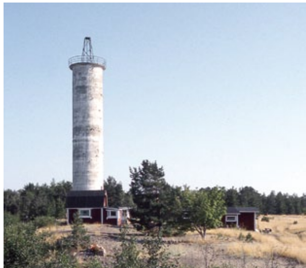
Harrbådanin loistotorni on Kokkolan rannikkoalueen näkyvimpiä maamerkkejä.
