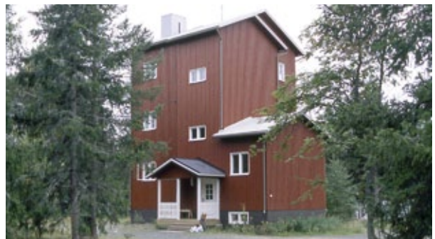
Martinniemen luotsiasemarakennus Haukiputaalla.
