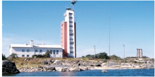
Kylmäpihlajan yhdistetty majakka- ja luotsiasemarakennus, korkeus maanpinnasta 32 metriä.
