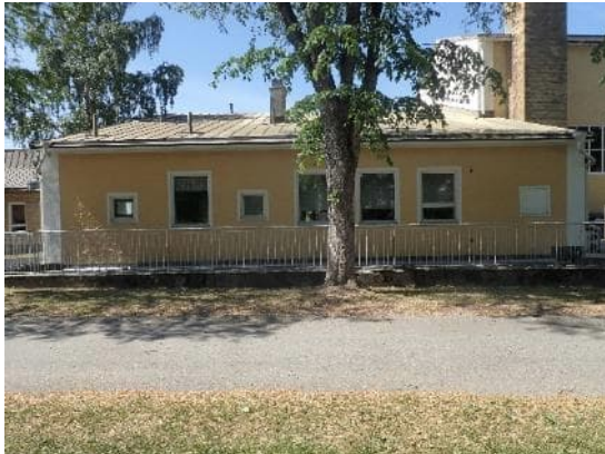
Kuvat 89 ja 90. A-osan ensimmäisen kerroksen ulkoseinissä ei havaittu vaurioita lukuun ottamatta kaakkoiskulmaa, jossa puuttuvan rännivesikaivon kohdalla havaittiin viitteitä kosteusrasituksesta (ympyröity).
