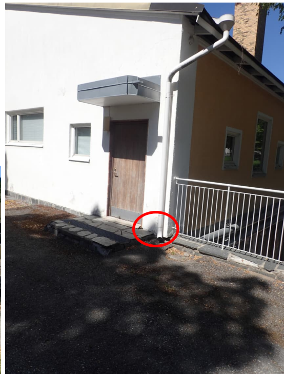
Kuvat 89 ja 90. A-osan ensimmäisen kerroksen ulkoseinissä ei havaittu vaurioita lukuun ottamatta kaakkoiskulmaa, jossa puuttuvan rännivesikaivon kohdalla havaittiin viitteitä kosteusrasituksesta (ympyröity).
