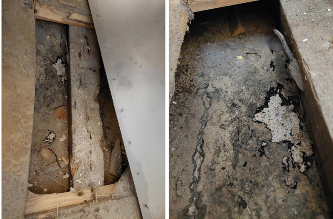
Kuvat 73 ja 74. E-osan alapohjan avaus R12.
