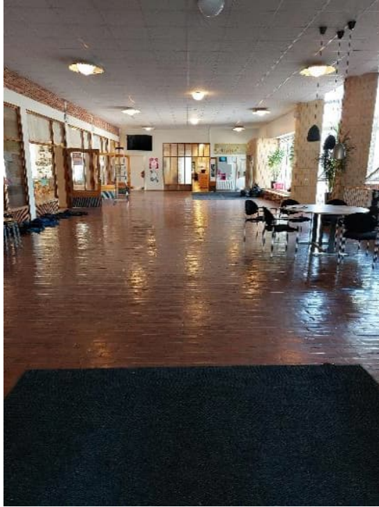
Kuvat 191 ja 192. Yleiskuva B-osan aulan tiilipintaisesta lattiasta ja välipohjan alla olevasta puurima-alakatosta.
