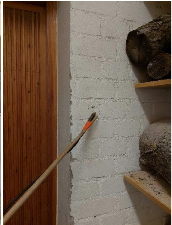
Kuvat 149 ja 150. Ulkoseinän ilmavuotopaikkoja, jotka havaittiin alapohjan merkkiainekokeessa MA9.
