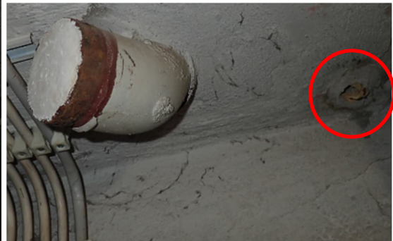
Kuva 189 ja 190. Viemärien välipohjaläpivienneissä oli palokatkot. Välipohjassa havaittiin avonaisia sähköputkia (ympyröity).
