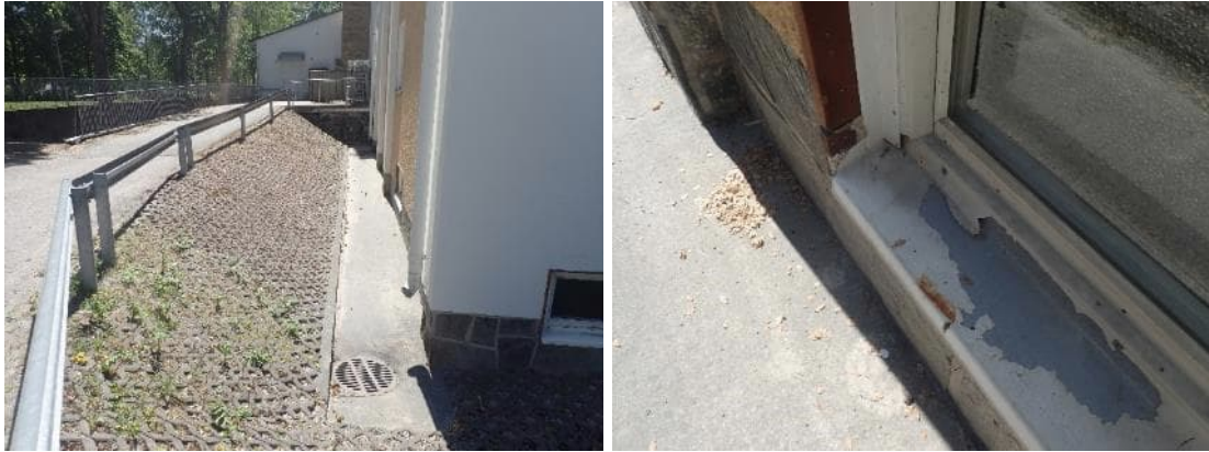
Kuvat 13 ja 14. C-osan kellarin portaissa on viemärointi keski- ja alatasanteella. Alatasanteen viemäroinnissä oli runsaasti lehtiä.
