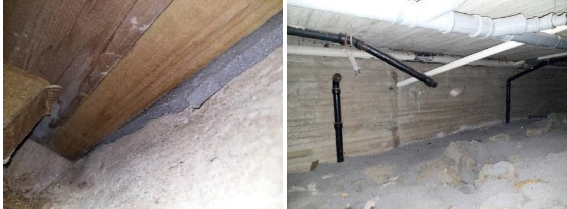
Kuvat 76 ja 77. E-osan alustilan muottilautoja ja katkaistuja käytöstä poistettuja putkia.
