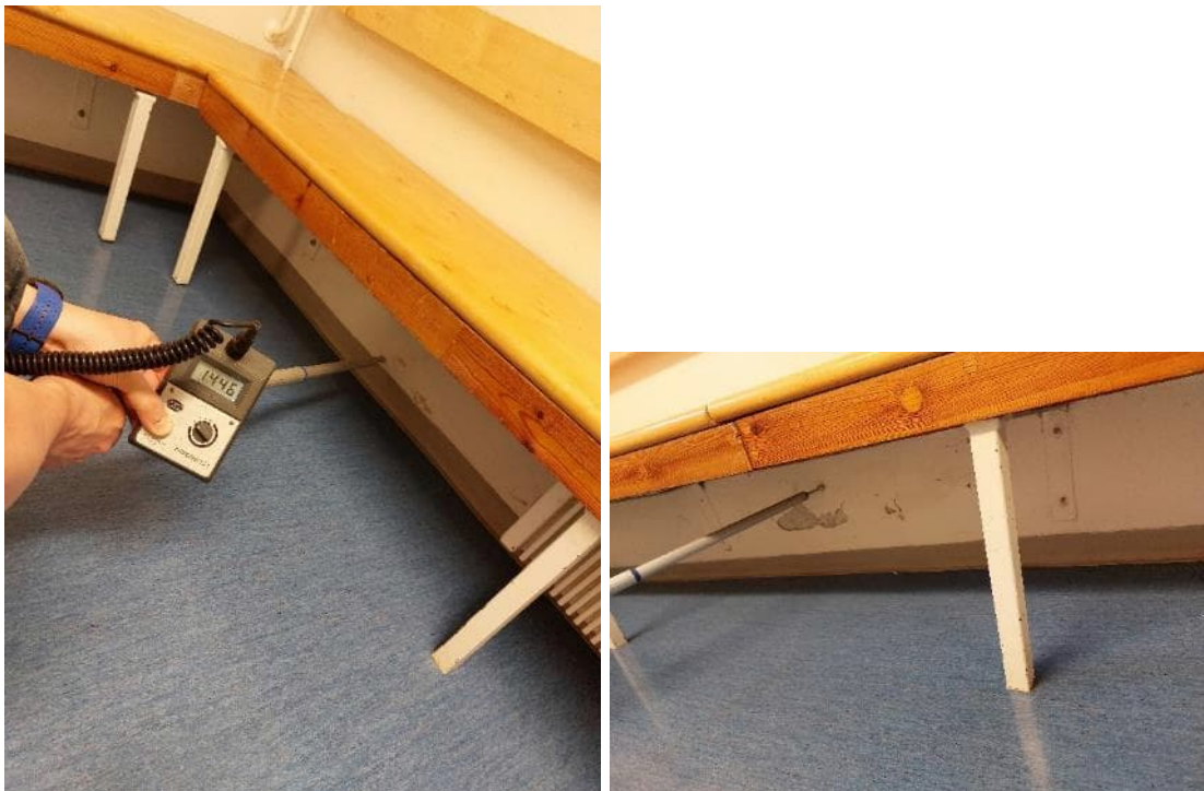
Kuvat 101 ja 102. Pukuhuoneiden 030 ja 034 maanvastaisissa seinissä havaittiin koholla olevia kosteusarvoja ja maalipinnan kupruilua.
