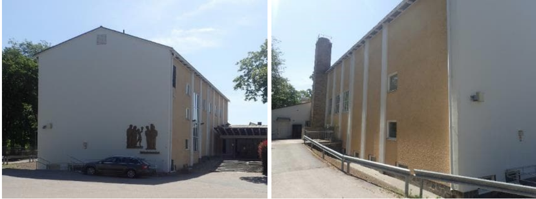
Kuvat 99 ja 100. C-osan julkisivuja.
