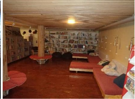
Kuvat 191 ja 192. Yleiskuva B-osan aulan tiilipintaisesta lattiasta ja välipohjan alla olevasta puurima-alakatosta.
