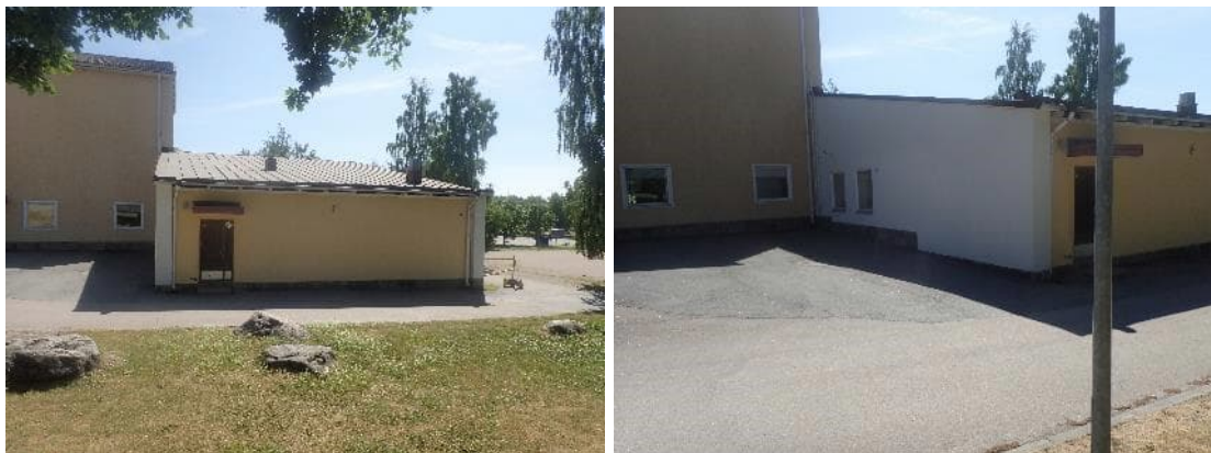
Kuvat 143 ja 144. G-osan pohjoinen ja itäinen julkisivu.
