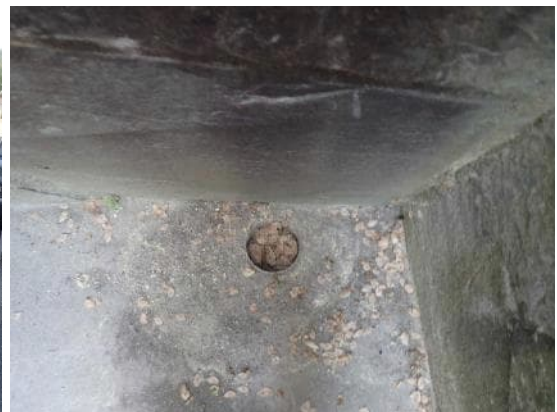
Kuvat 11 ja 12. C-osan kellarin portaissa on viemäröinti keski- ja alatasanteella. Alatasanteen viemäröinnissä oli runsaasti lehtiä.
