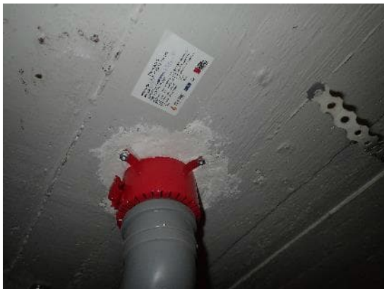
Kuva 189 ja 190. Viemärien välipohjaläpivienneissä oli palokatkot. Välipohjassa havaittiin avonaisia sähköputkia (ympyröity).
