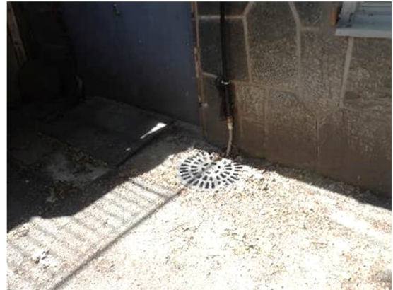
Kuvat 18 ja 19. Teknisiin tiloihin johtava luiska on viemäroity alatasanteelta.
