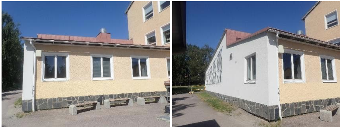
Kuvat 141 ja 142. G-osan eteläpuolen ulkoseinä on maalattu uudelleen ikkunoiden alapuoliselta osalta.
