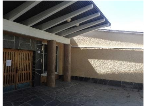
Kuvat 7 ja 8. Rakennuksen pääportaat ja pääsisäänkäynnin tasanne ovat liuskekivipintaisia.
