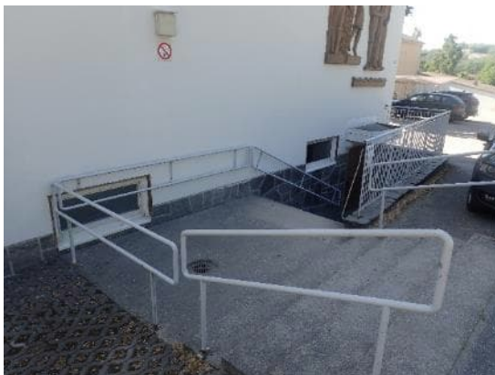
Kuvat 11 ja 12. C-osan kellarin portaissa on viemäröinti keski- ja alatasanteella. Alatasanteen viemäröinnissä oli runsaasti lehtiä.
