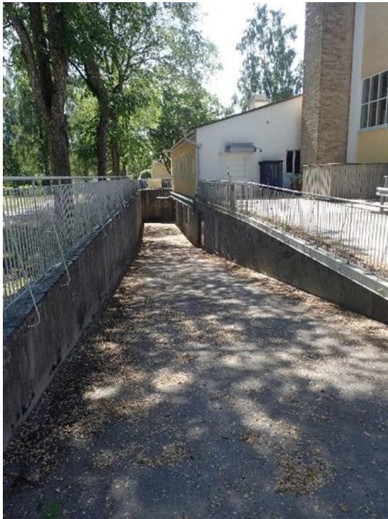
Kuvat 18 ja 19. Teknisiin tiloihin johtava luiska on viemäroity alatasanteelta.
