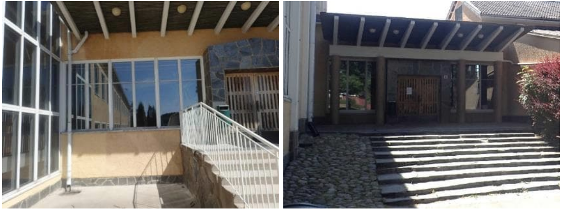
Kuvat 95 ja 96. B-osan sisäänkäyntien kohdilla on katokset, jotka kallistavat kohti rakennusta.
