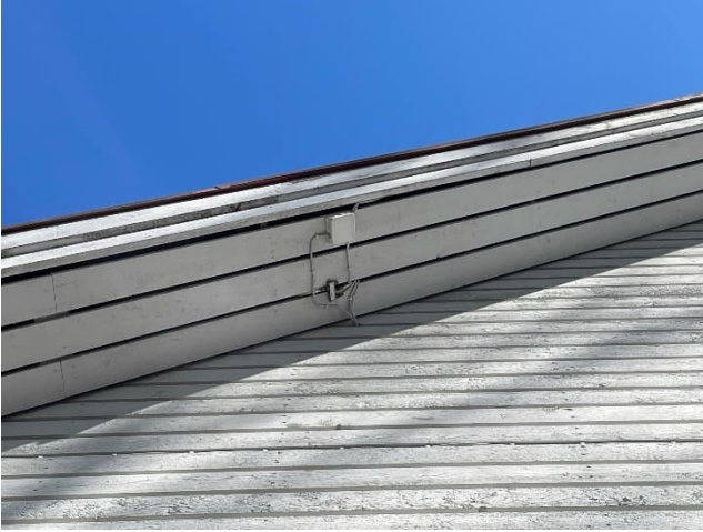
Antennijaotin räystäslaudoituksessa.
