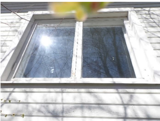
Alkuperäinen 2-puitteinen ja 2-lasinen maalattu puuikkuna.
