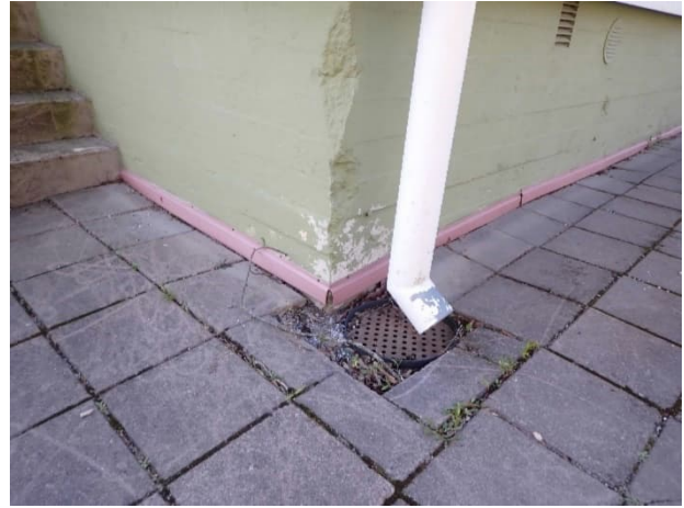
Sokkelin maalipinnan paikallista hilseilyä syöky- torven takana. Patolevyn ei ylety listaan asti nur- kassa.
