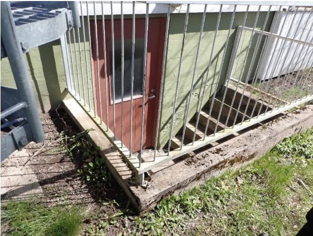
Alkuperäinen kellarin ovi.
