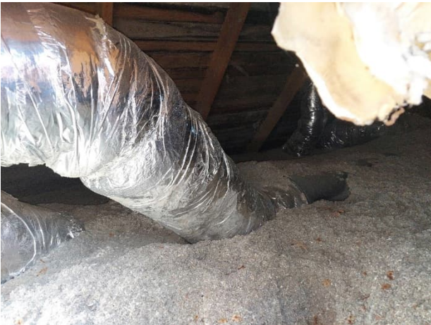
Korkea yläpohjatila ja yläpohjan puhallusvillaeristettä.
