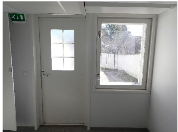
Kellarin uusittu ovi.
