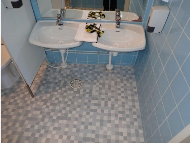
Toisen kerroksen wc-tila.
