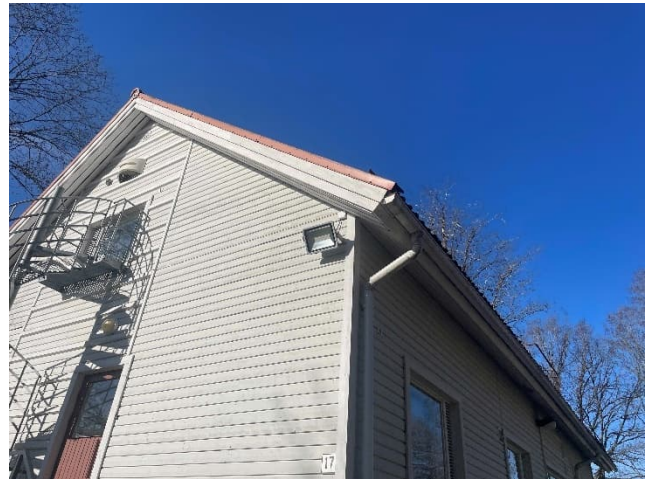
Ulkoseinän uusittu LED-valaisin.
