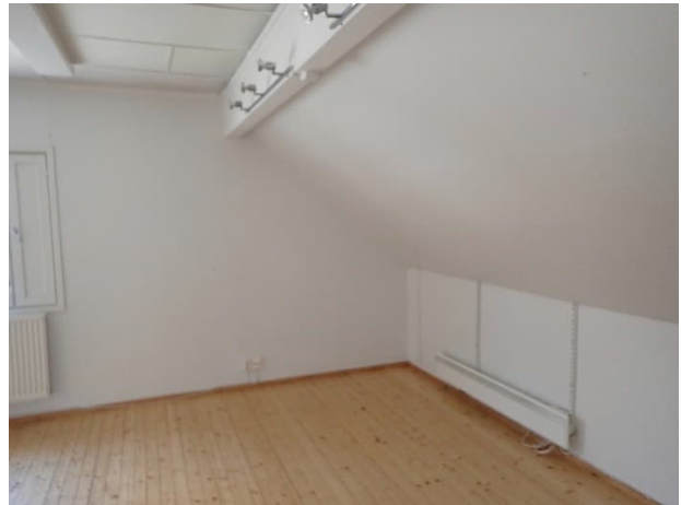
Itäpäädyn jälkikäteen rakennettuja ulkoseiniä, kun sivuvintit on otettu huonetilaksi.
