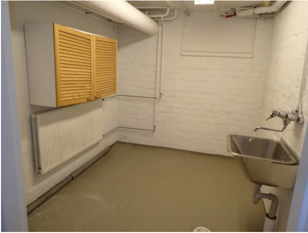
Osassa maanvastaisia seiniä on näkyvillä alkupe- räinen sisäpuolen tiilimuuraus.
