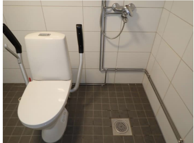
Kellarikerroksen saneerattu wc-/pesutila.
