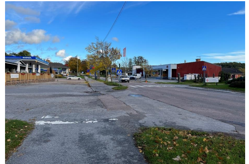
Kuva 18. Nauvon keskustassa jalankulku- ja pyörätien päällyste on huonossa kunnossa ja suojiemerkinnyt kokonaan kuluneet pois.
